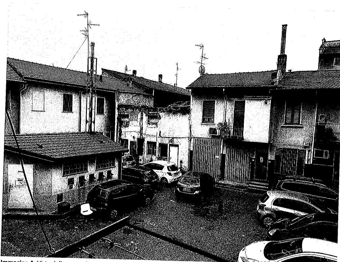
Immagine A. Vista della corte che corrisponde al civico 4 di via Rocca d'Anfo. In fondo a sinistra il fabbricato in cui si situano le unità immobiliari oggetto di valutazione.
